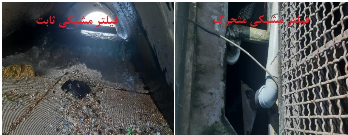
شکل ۲- نمایی از فیلترهای مشبک نیروگاه شهید مفتاح همدان
